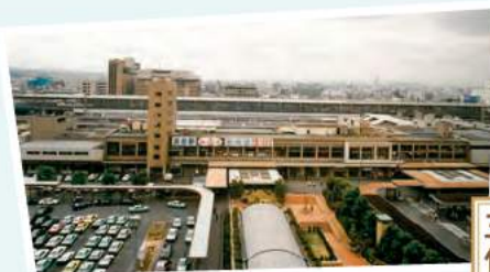
鉄筋コンクリート造りの近代的な3代目駅舎。 総工費4億2400万円で、2代目駅舎より7倍も大きく、 初代から比べると12倍もの大駅舎
